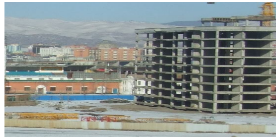
郊外のマンション建設現場
